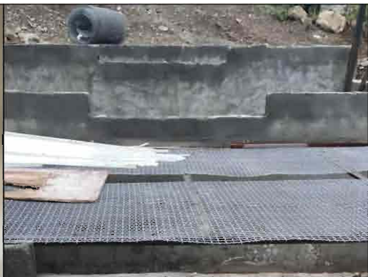
三级淋溶水沉淀池
