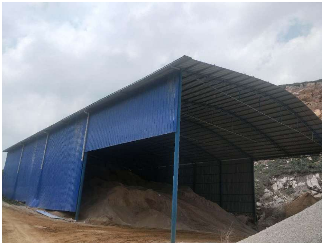
封闭式产品堆场
