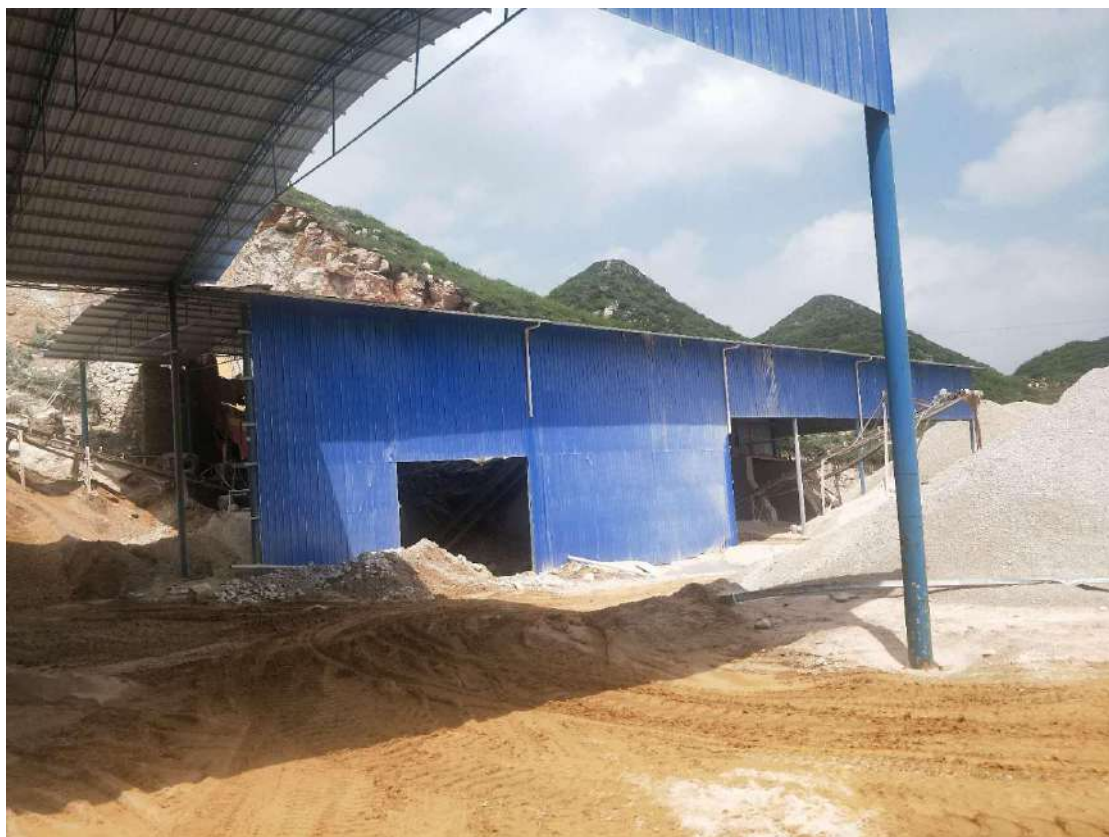
封闭式生产车间
