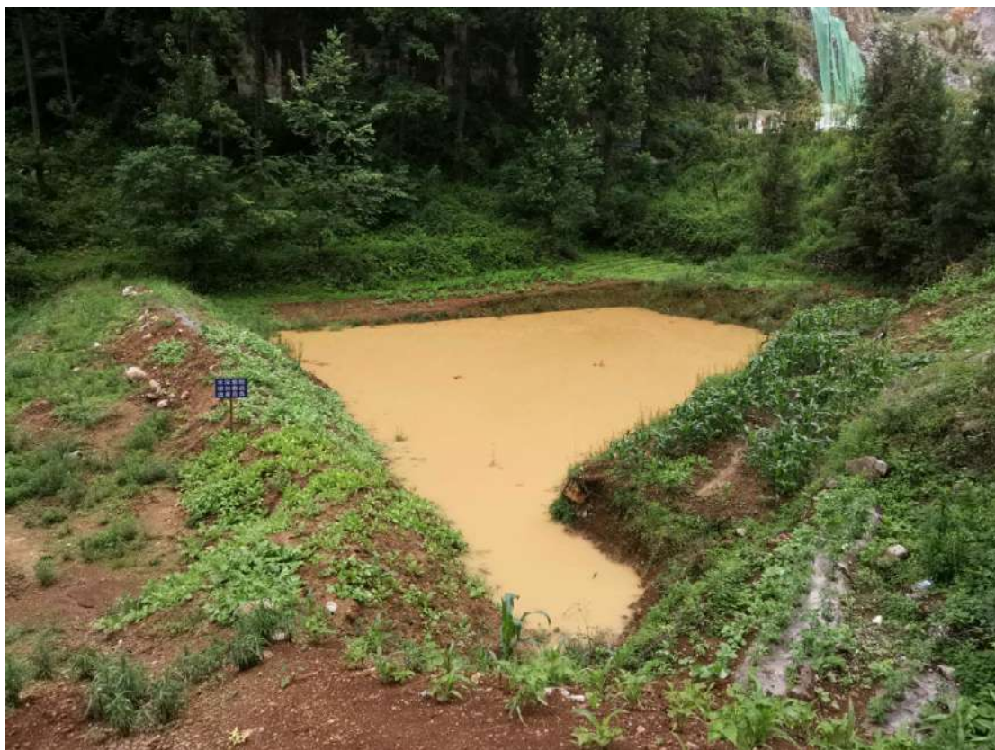
生产及辅助生产区沉砂池
