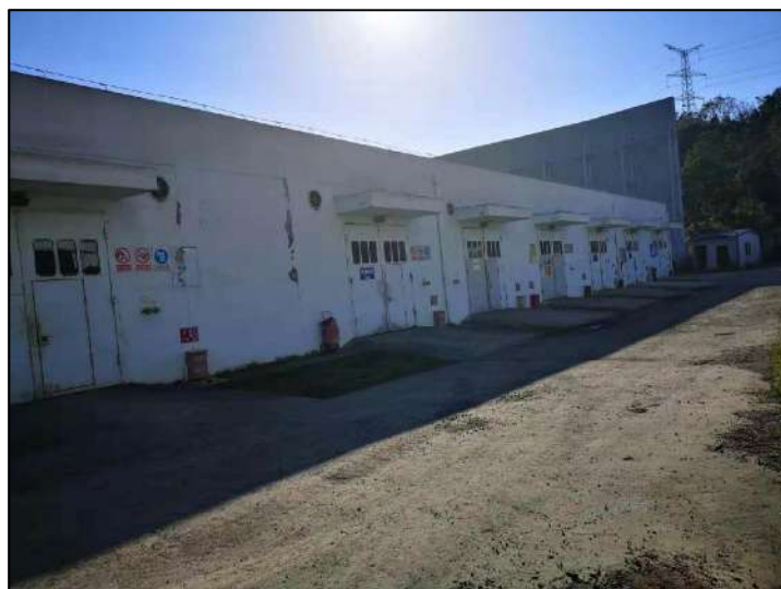
危險废物暂存间
