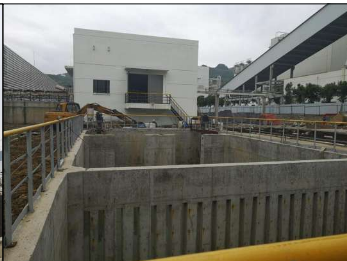
1号雨水收集沉淀池
