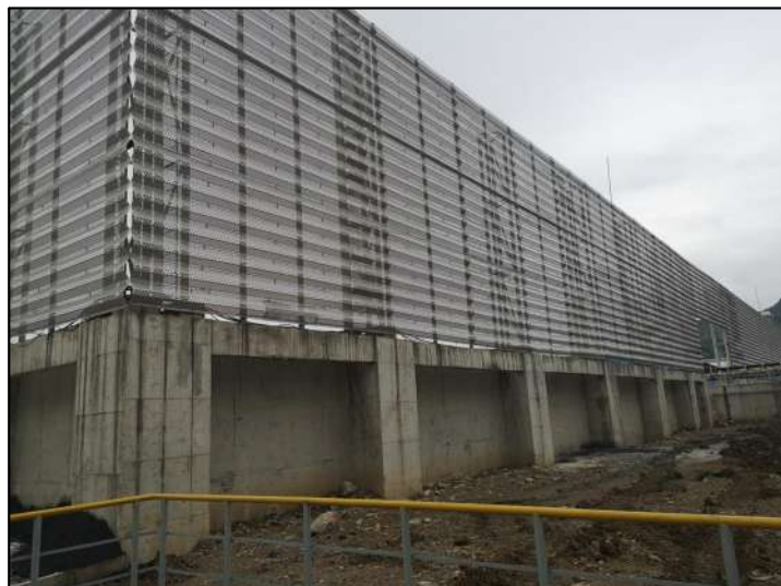
防风抑尘网及围墙
