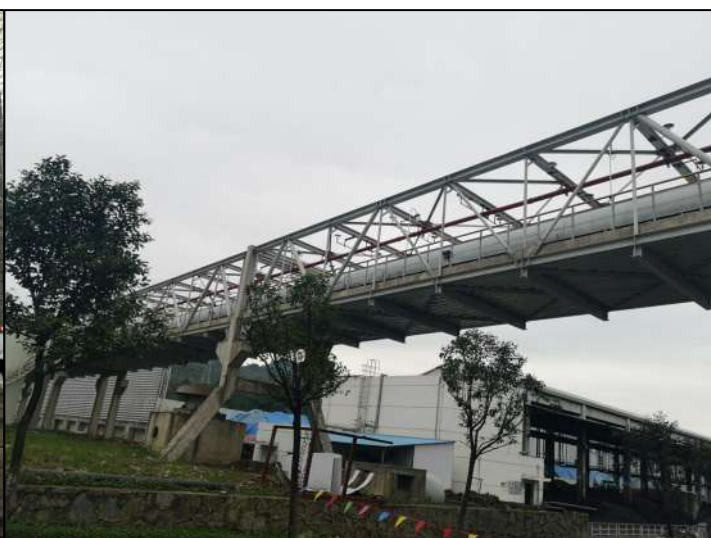
封闭式输送皮带
