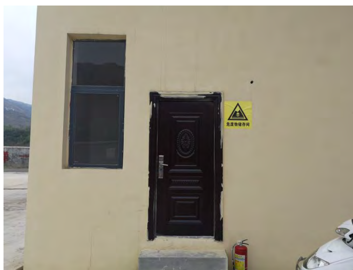
危险废物暂存间
