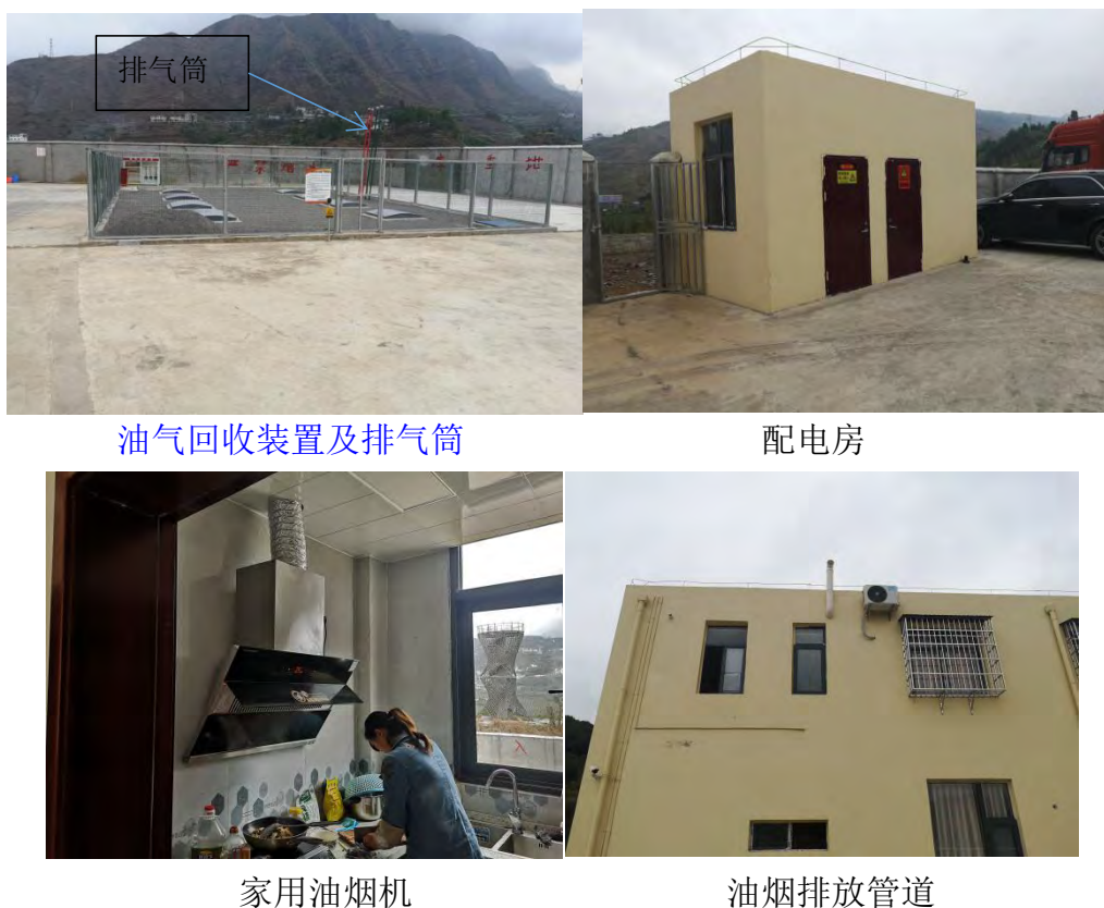
图4 废气处理措施
