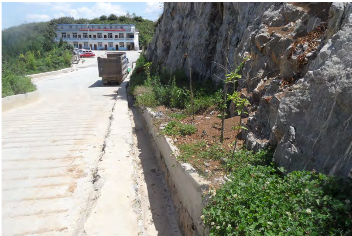
厂内道路治理现状(2020 年 6 月 16 日照)
