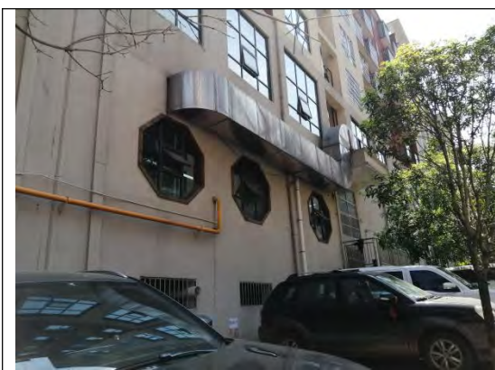
商业住房废气排放通道
